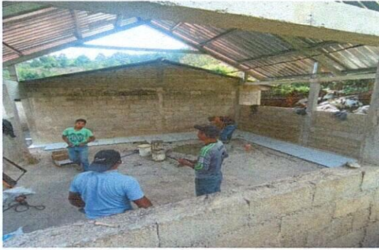
Foto1: Colocación de piso cerámico en el aula nueva.
