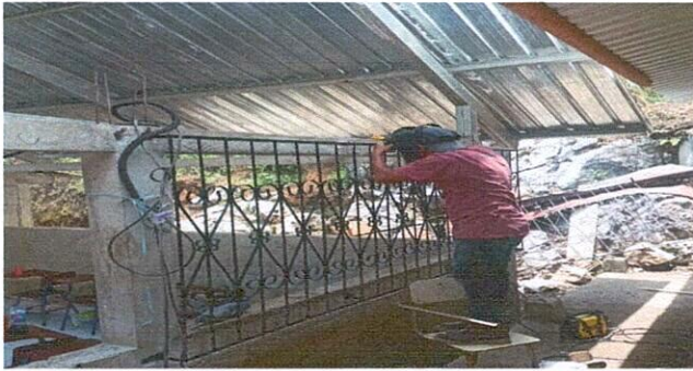
Foto1: Instalación de 6 balcones y 6 ventanas en esta clase
