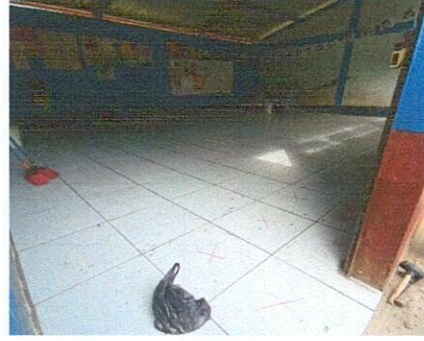
Foto 2: Instalación de piso cerámico en el aula de preprimaria.
