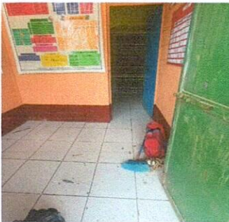
Foto 3: Colocación de piso cerámico en la dirección.
